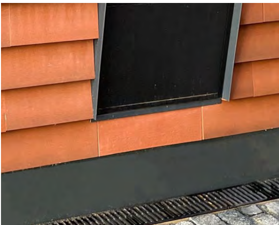
Entwässerung im Sockelpunkt / drainage in the ground base
