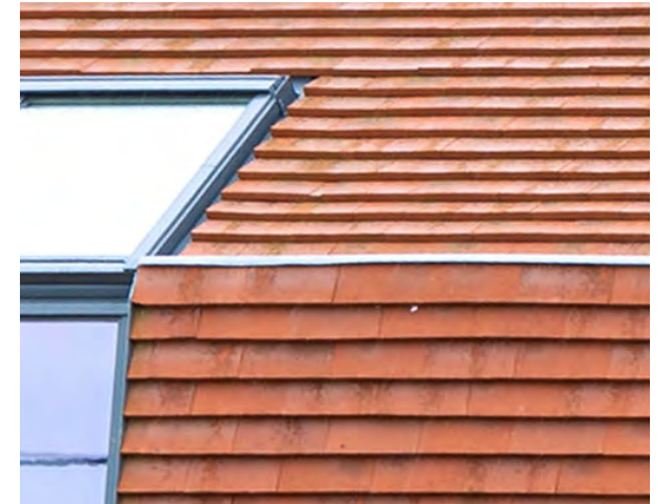
Außenecke spitz / external corner pointed
