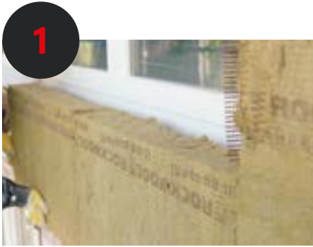
1 Ansetzen der Dämmplatten an die Fassade
