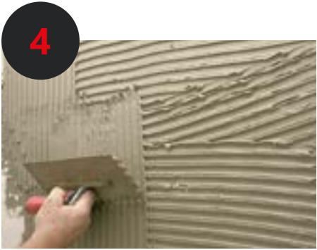
4 Auftragen des Klebers
