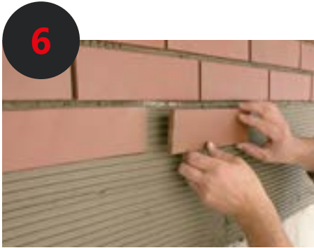
6 Ansetzen der Riemchen in den Kleber
