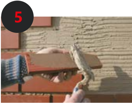
5 Auftragen des Klebers auf das Riemchen (Buttering-Floating-Verfahren)
