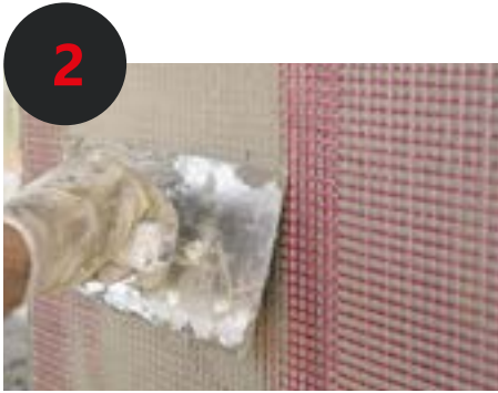
2 Aufbringen einer Armierungsschicht
