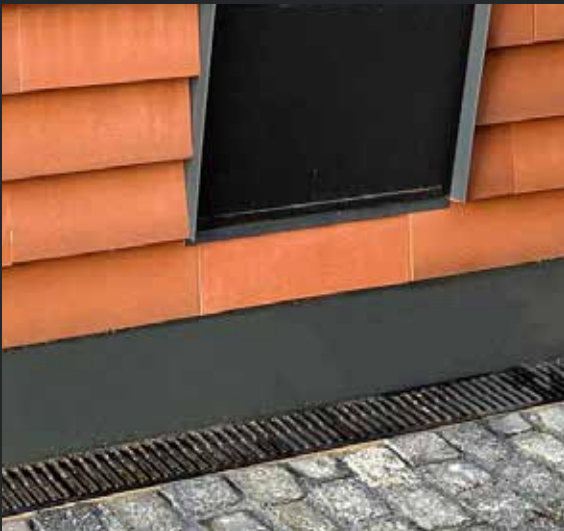
| Entwässerung im Sockelpunkt
