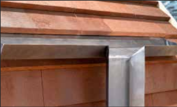
| Entwässerung im Sockelpunkt
