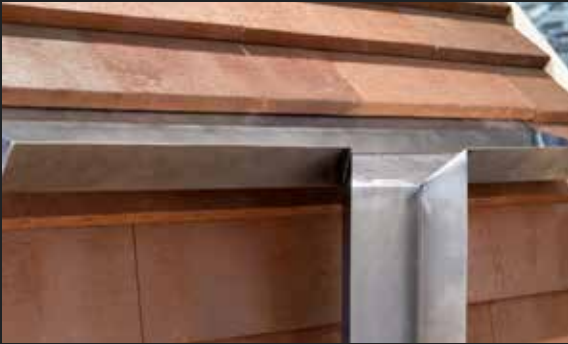
| Entwässerung im Sockelpunkt
