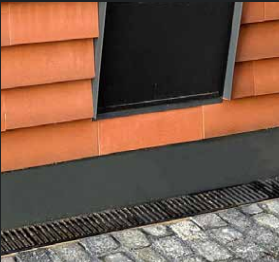
| Entwässerung im Sockelpunkt
