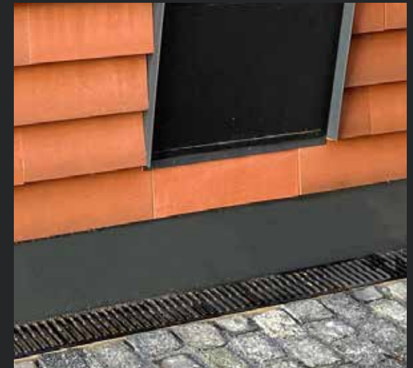
| Entwässerung im Sockelpunkt
